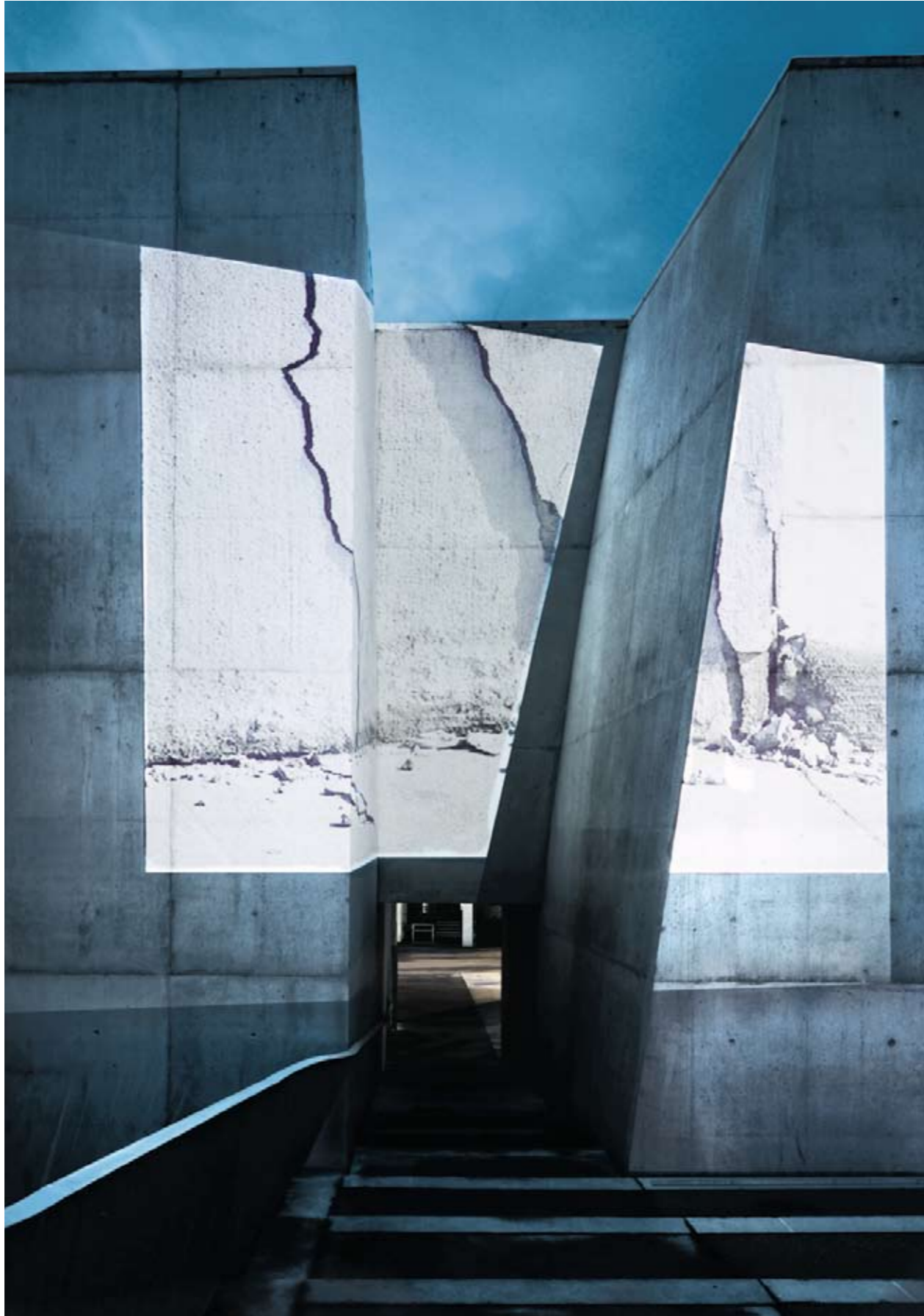
Erdbebenschaden im Museum Franz Gertsch in Burgdorf. War das Naturereignis vorhersehbar? Dégâts occasionnés par un tremblement de terre au musée Franz Gertsch à Berthoud. La catastrophe naturelle était-elle prévisible?
