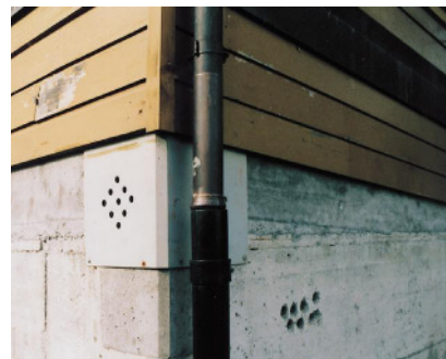
Verdeckte Aussparung für hydraulische Presse
